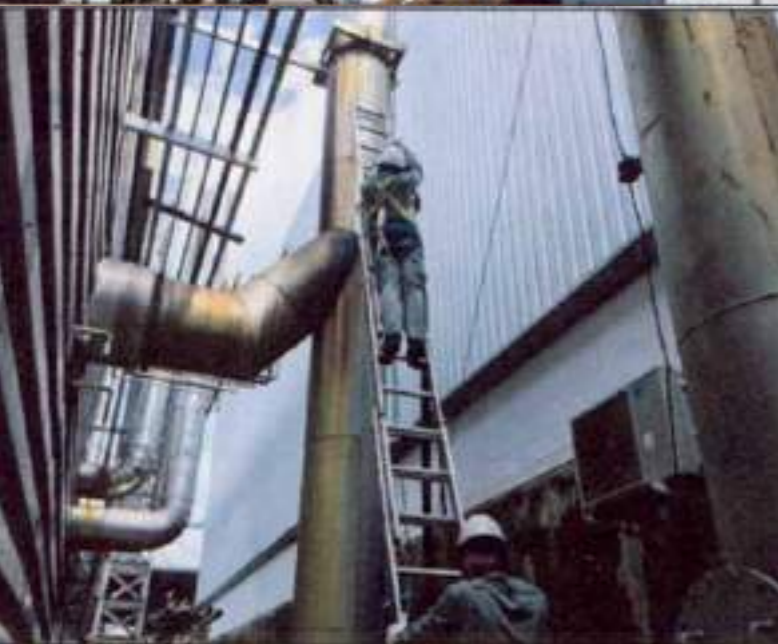
ภาพที่ 3: การเก็บตัวอย่างอากาศจากปล่องระบายอากาศ Boiler Stack No.10 B5 B6
