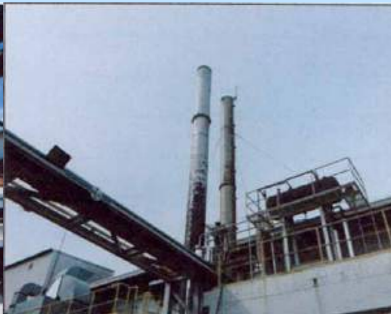
ภาพที่ 2: การเก็บตัวอย่างอากาศจากปล่องระบายอากาศ Boiler Stack No.9 BOPET
